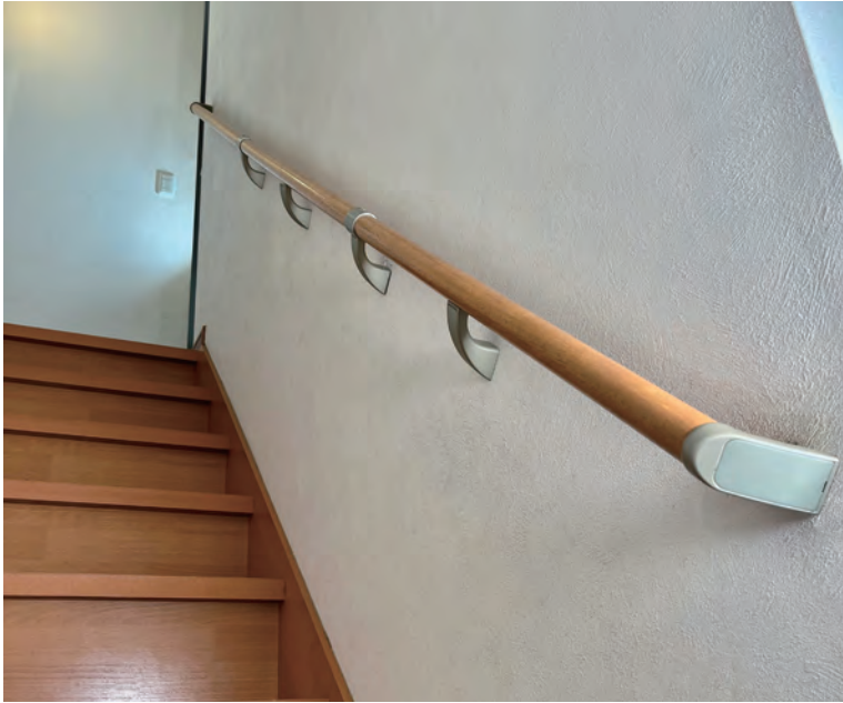
3本継手 階段手すり(エンドブラケット型)
