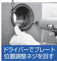
ドライバーでプレート位置調整ネジを回す
