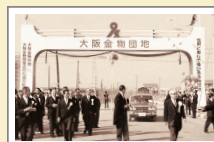
東大阪金物団地着工(1967年)
