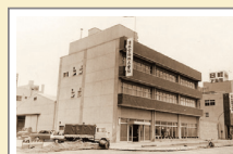
建設中の旧本社
