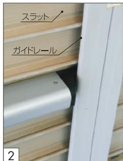
2 片方を隙間(スラットとガイドレールの間)に差し込みます。
