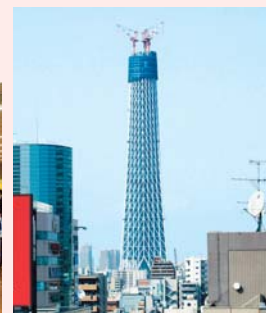
▲会場から見た建設中の「東京スカイツリー」
