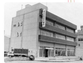
建設中の旧本社
