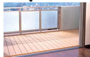
マンションデッキ施工例
