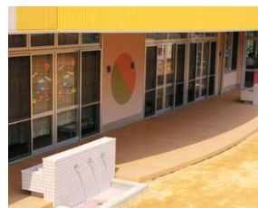
幼稚園施工例
