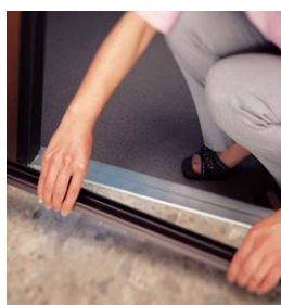
ドアクローザをよける取付け例 ※ドアクローザがない場合でも高さ調整に利用します。
