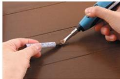
【かくれん棒フローリング用】をコテ先で溶かしながら、キズ部分に盛り上げるように流し込みます。
