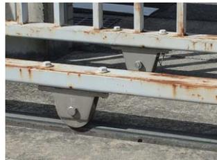
材質 枠:鉄 SPCC 車:S45C
