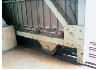
材質 枠:鉄 SPCC 車:S45C
