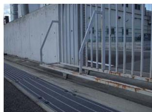
材質 枠:鉄 SPCC 車:S45C
