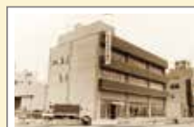
建設中の旧本社
